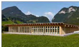
производственный цех в Грюше
